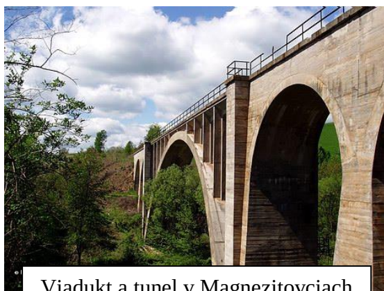
Viadukt a tunel v Magnezitovciach
